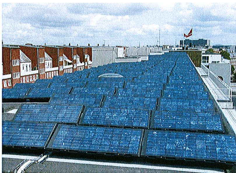
Eksempel på solcelleanlæg – SiD-bygningen.
